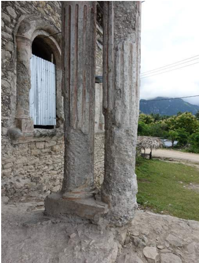
Foto 5 – Pormenor das colunas da entrada principal e do seu estado de degradação Autor: Fernando Carvalho
