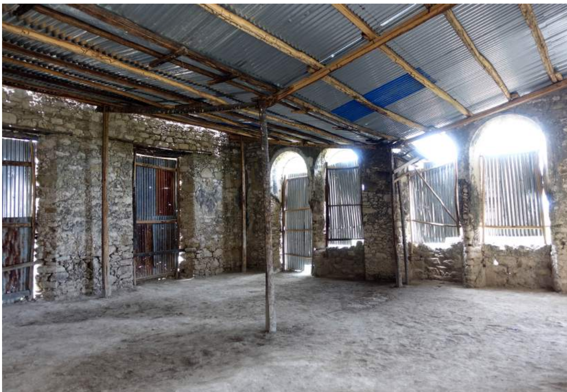
Foto 4 – Uma das salas de aula improvisada por alunos e professores através da colocação de placas de zinco Autor: Fernando Carvalho
